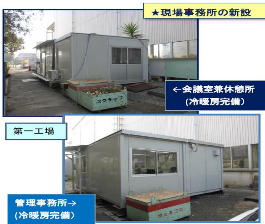
写真 60 現場事務所の新設
