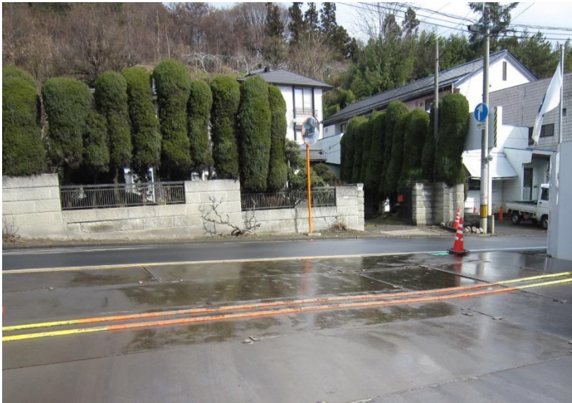
写真 13 搬出入口の敷鉄板段差の見える化とカーブミラーの設置
